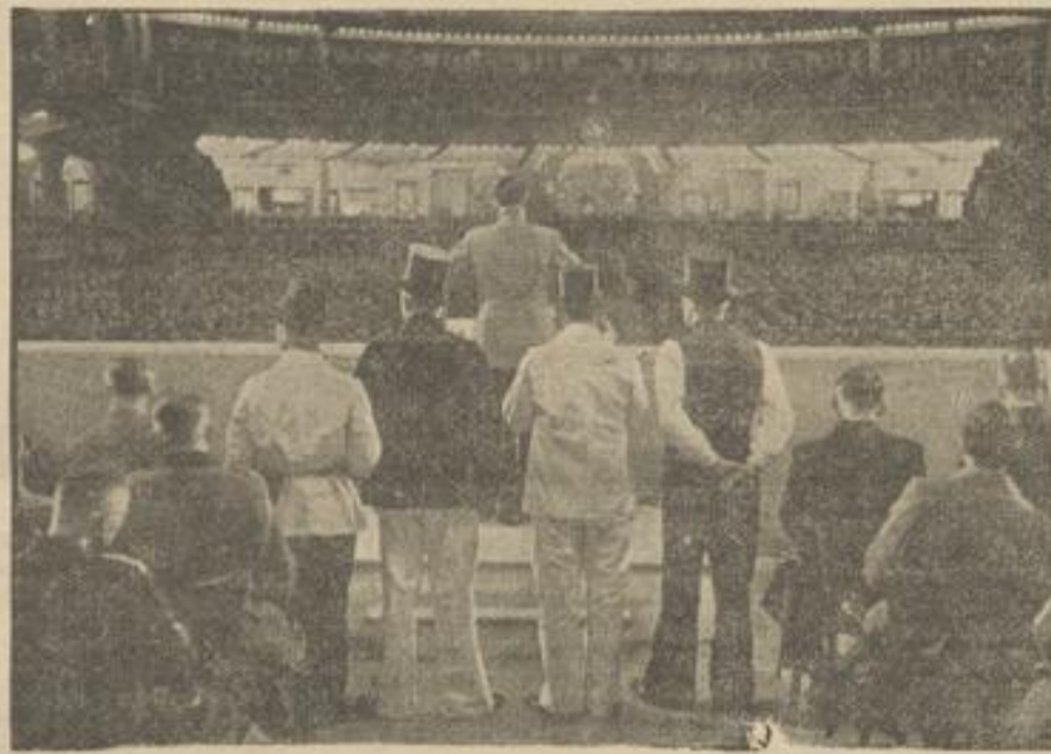
Ein bedeutender Moment in der Neugestaltung der Reichshauptstadt Der Führer spricht auf der Feier zur Einweihung des Neubaus der Reichskanzlei zu den rund 8000 Arbeitern, die an diesem Riefenbau gearbeitet haben. Weltbild (M)
