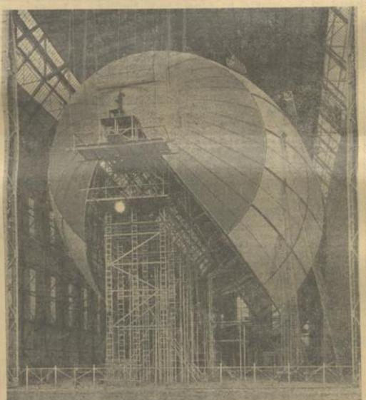
Ein modernes Lultschiff wird gebaut. Auf LZ 129 wird in der Werft von Friedrichshafen ge(RS.-Verfie-Bilbarthin, 4.)
