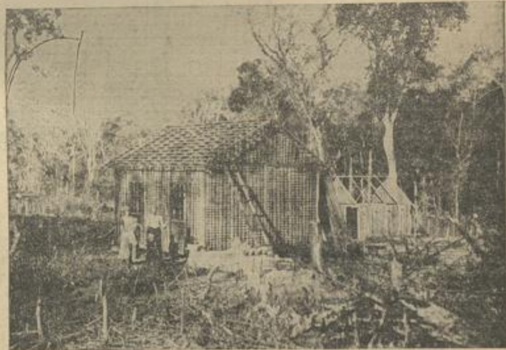
Schwäbische Kolonisten beim Bau ihres Hauses in der Kolonie „Suevia“ in Sao Paulo
