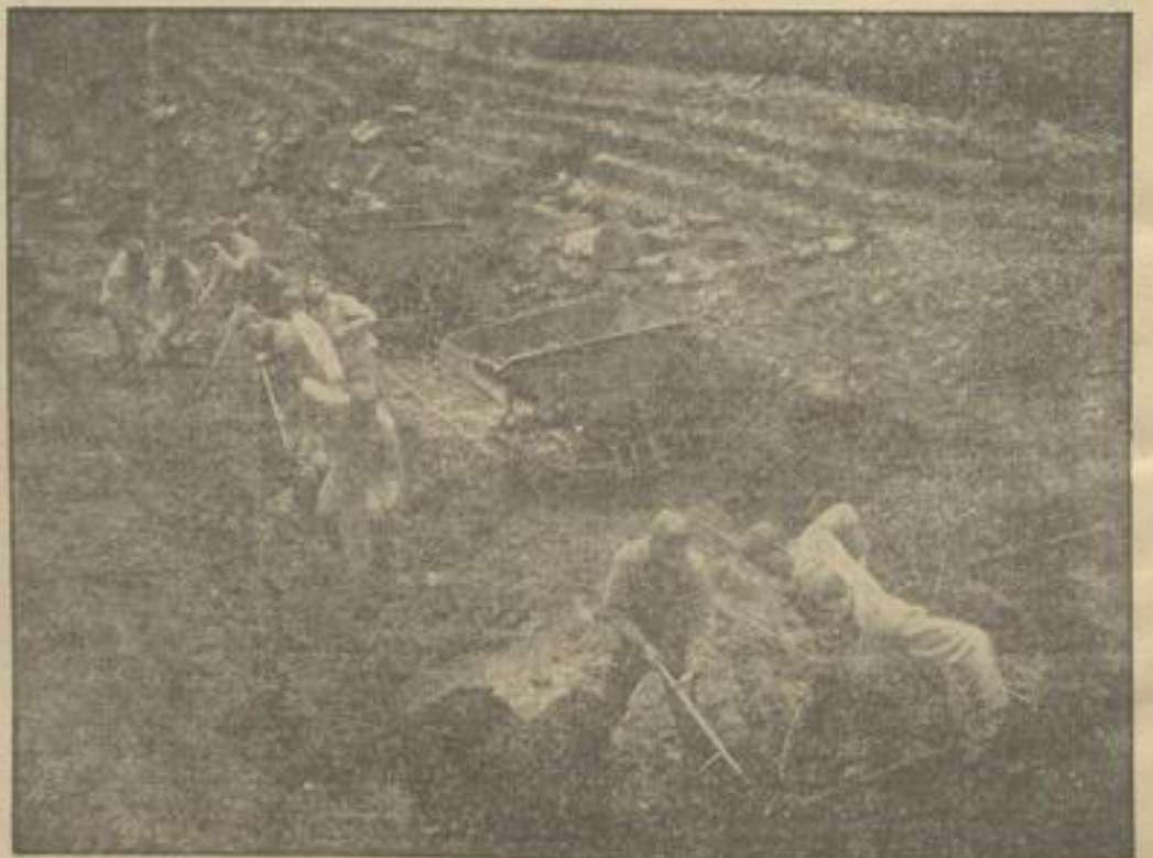
Eine Gruppe Arbeitsmänner bei der Ausschachtung des neuen Feuerbachbettes
