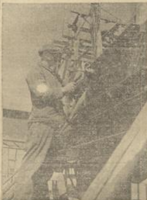
Niete an Niete — so entsteht das Stahlgelüst der Sulzbachbrücke
