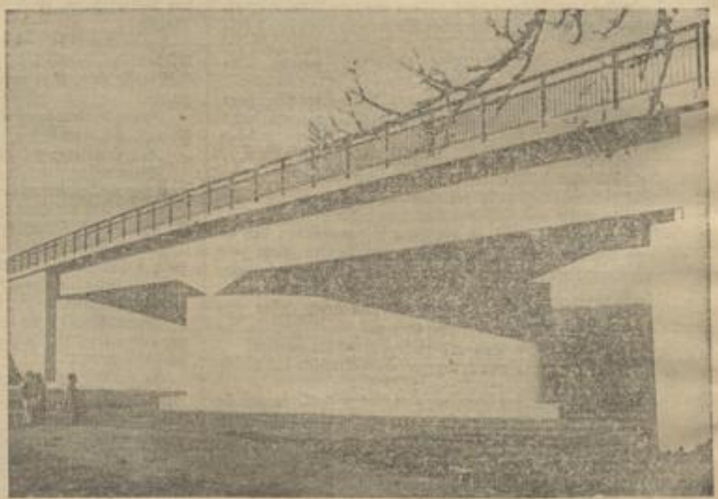
Die Straßenüberführung Pfenningen—Neuhausen
