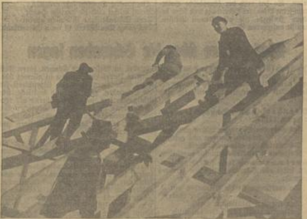
Zimmerleute beim Aufbauen des Dachstuhl Aufnahme: Eberhard Wilderdt
