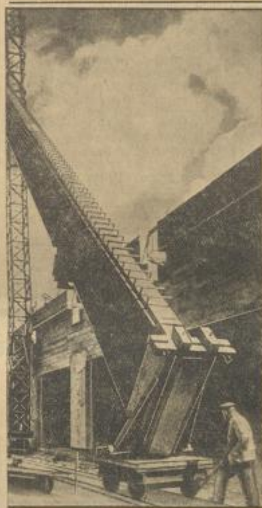
Einer der gewaltigen 84 Meter hohen eisernen geschweißten Rahmen des Parteitages.
