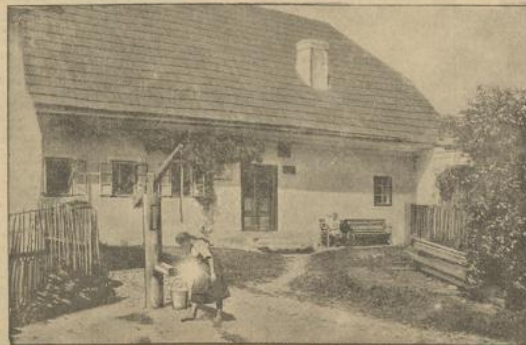
Das Geburtshaus des Dichters Adelbert Stifter in Oberplan (Böhmerwald) wurde durch Brandstiftung zerstört
