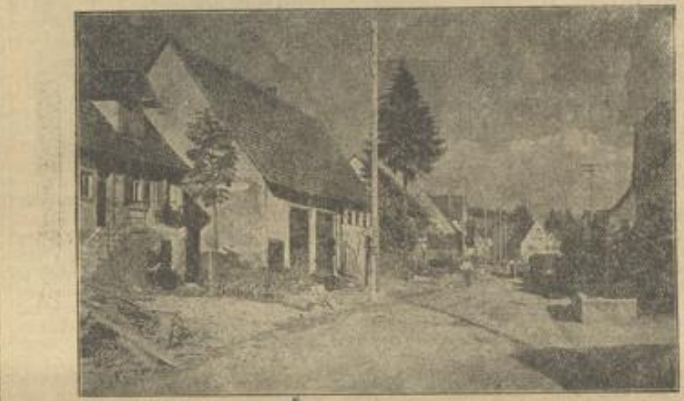
Dorfstraße in Gerlingen auf der Alb; Häuser mit Langfront an der Straße; das kahne Straßendach durch die Baumkronen wölbt sich über (H. Meyhing)
