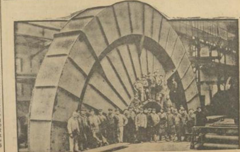
Arbeiter einer Bochumer Fabrik vor dem Ventilator, dem größten in der ganzen Welt, der hier fertiggestellt wurde. Das Flügelrad hat einen Durchmesser von 10,3 Metern und vermag eine „Wettermenge“ von 20 000 cbm in der Minute zu fördern. Das Gewicht des Ventilators allein, ohne Welle und Antriebsmaschine, beträgt 98 000 kg.
