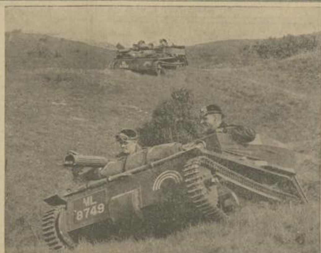
Für diese Klein-Tanks gibt es keine Bodenhindernisse mehr
