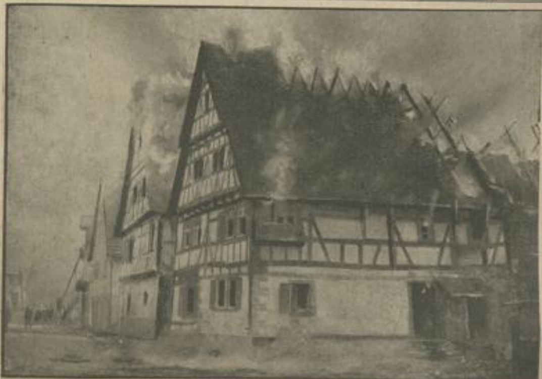
Der Brand fröh sich durch die Reihen der Fachwerkhäuser.
