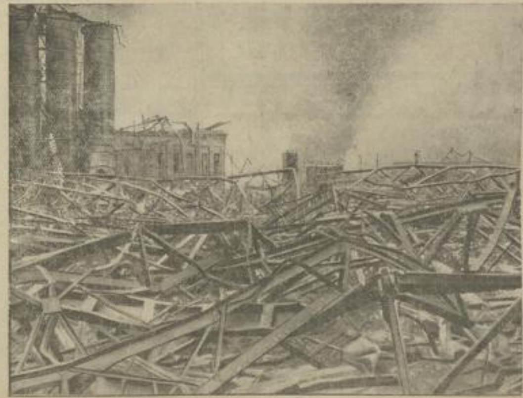
Das zusammengestürzte Eisengerüst des großen Hofameters.
