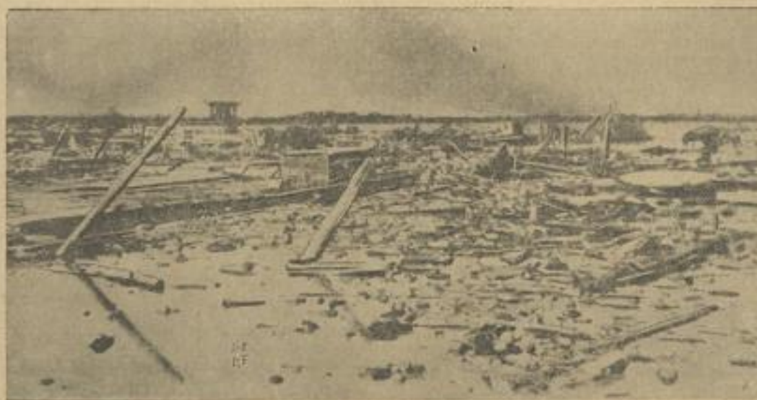
Echtes Originalbild von der W. G. S. Kerm-Restruktion auf Ruina
