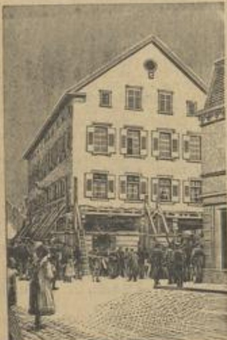
Das gehobene Gasthaus zum Dirsch kurz vor dem Einsturz.
