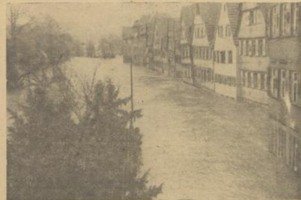
2 Bilder vom Hochwasser in Calw
