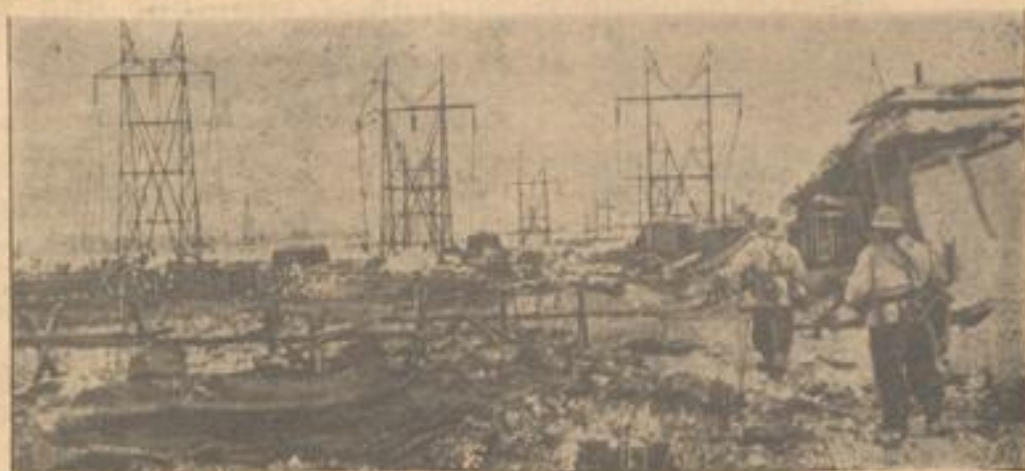
Flugbahn in Krasnodar, die als „schlecht“ es um die Reichsverordnung der Beschleunigung der Fertigstellung des Fertigmateri...
