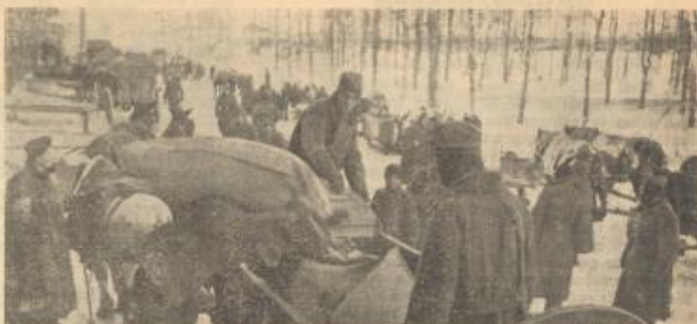
Hochbetrieb vor dem Verpflegungsamt im Osten
