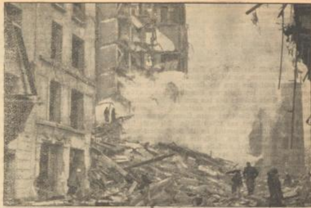
Die erste Aufnahme vom englischen Bombenangriff auf Paris. So sieht es nach dem fastblütig organisierten Bombenangriff in den betroffenen Wohnvierteln von Paris aus. Ganze Häuserreihen sind in den Arbeiterbezirken wie zerstört. (PK-Aufnahme: Kriegsberichterst. Weinmann, P.B., 3.)
