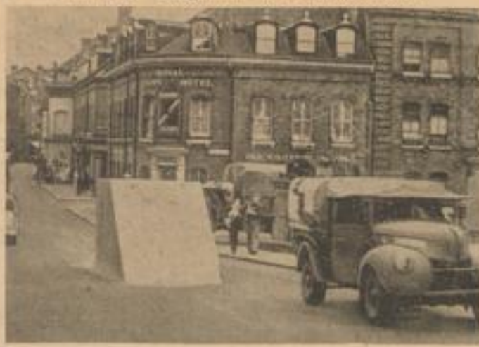
Betonträgerwerke an einer Brücke, irgendwo in England“
