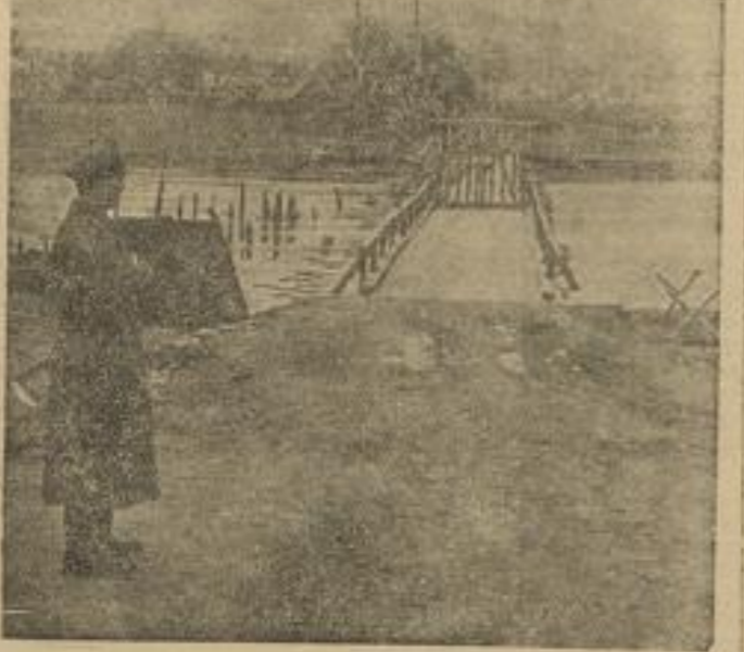
Weltbild (30). Grenzbrücke über den See bei Sanot. Im Hintergrund sieht man das russische Ufer.
