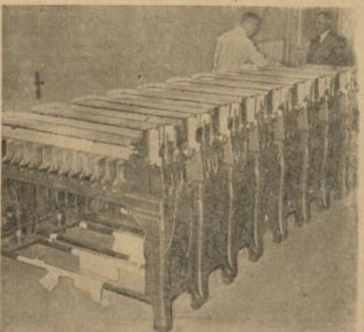
Eine der 70 Sortiermaschinen, durch die die Briefsorten der deutschen Volkszählung in die gewünschte Reihenfolge gebracht werden
