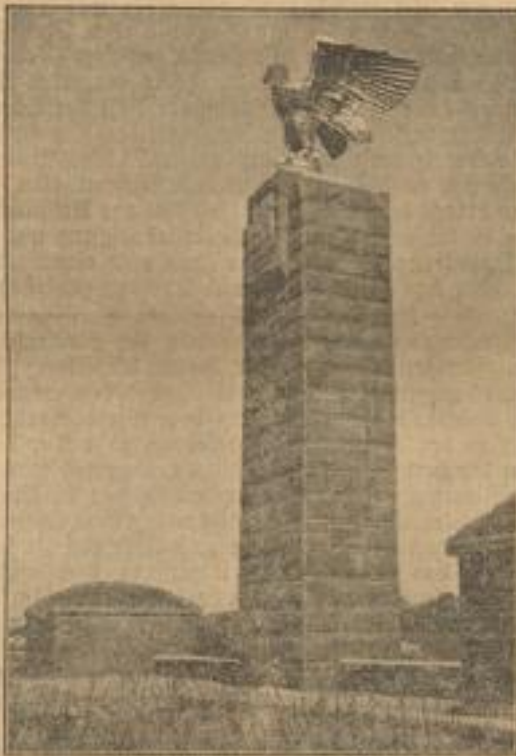
Das U-Boot-Denkmal an der Kieler Förde... erbaut von Welland Deutsche Reichsbahnbauverwaltung.
