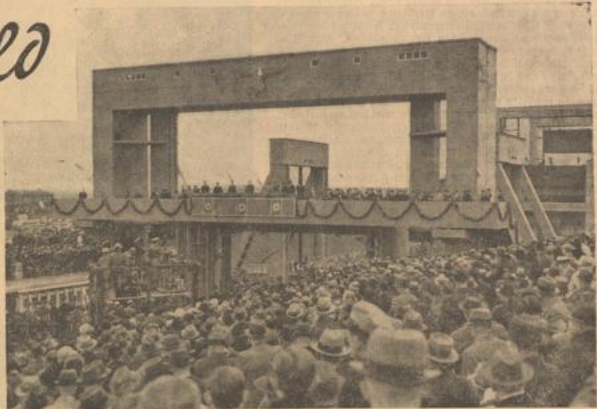
Links: Straßenbarrikaden an den wichtigsten Punkten der Altstadt Jerusalems nach der Besetzung durch die Engländer. — Oben: Bild auf das Schiffshörschiff bei Magdeburg während der Einweihungsfeier, mit der zugleich der Mittellandkanal, die Verbindung der Wasserstraßen im Westen und Osten des Reiches, eröffnet wurde
