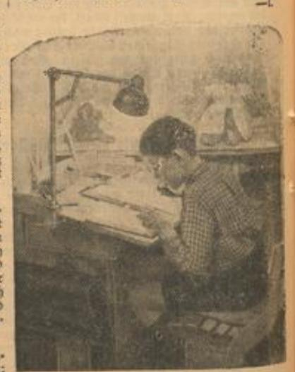
Dieser Arbeitsplatz des Schulkindes ist richtig beleuchtet. Außer der im Zimmer vorhandenen Allgemeinbeleuchtung ist am Schreibtisch ein verstellbarer Tischstrahler mit einer 60-Watt-Lampe so angebracht, daß die Schreibfläche blendungsfrei beleuchtet wird und keine lärende Schatten aufstreuen, was zur Schonung der Augen wichtig ist.
