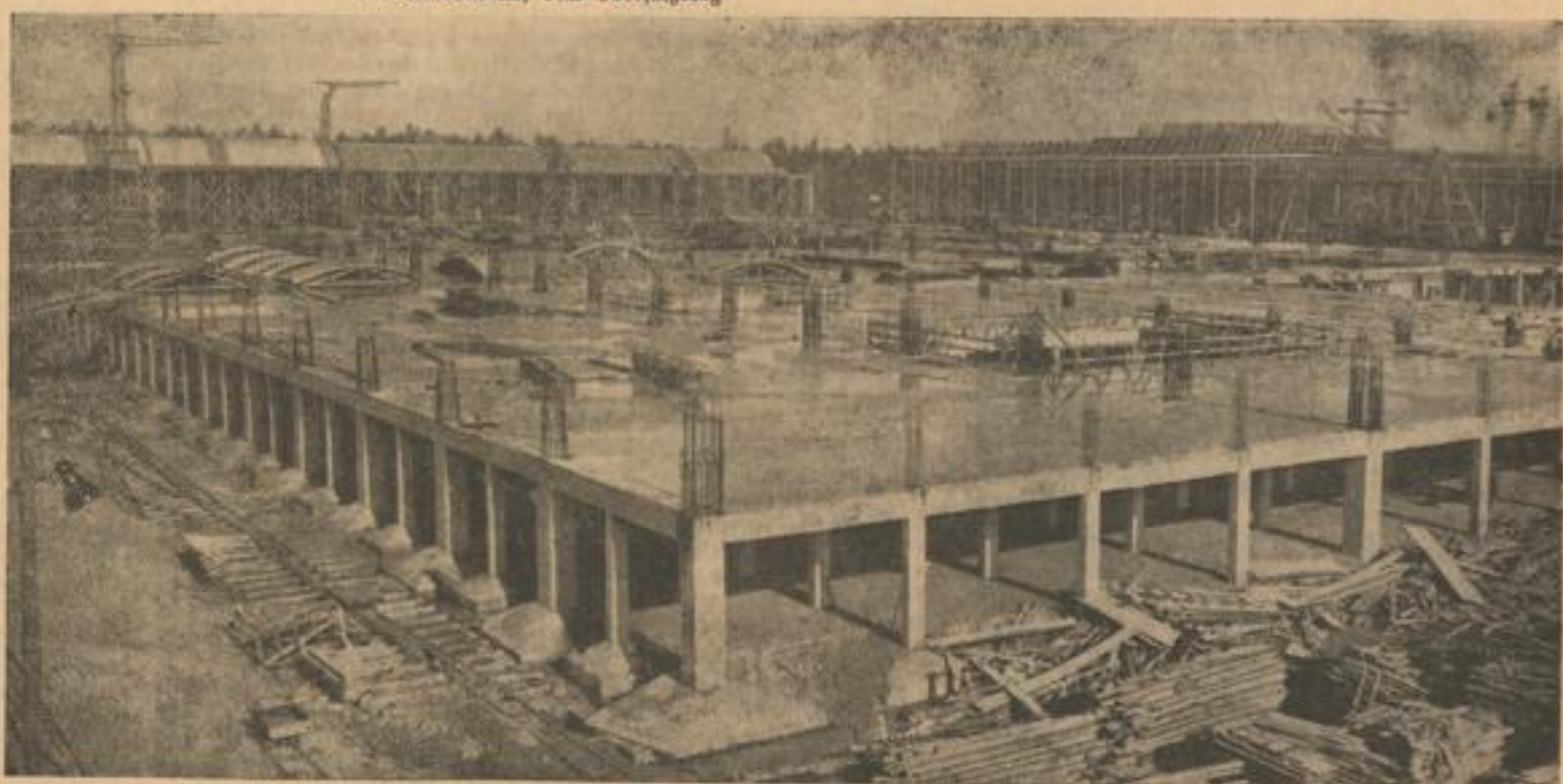
4000 Arbeiter sind in der Nähe von Jallersleben mit dem Ausbau des Volkswagenwerkes beschäftigt, das bereits in einem Jahr in Betrieb gesetzt und von 1940 ab alle 2 Minuten einen fertigen KdF-Wagen liefern wird
