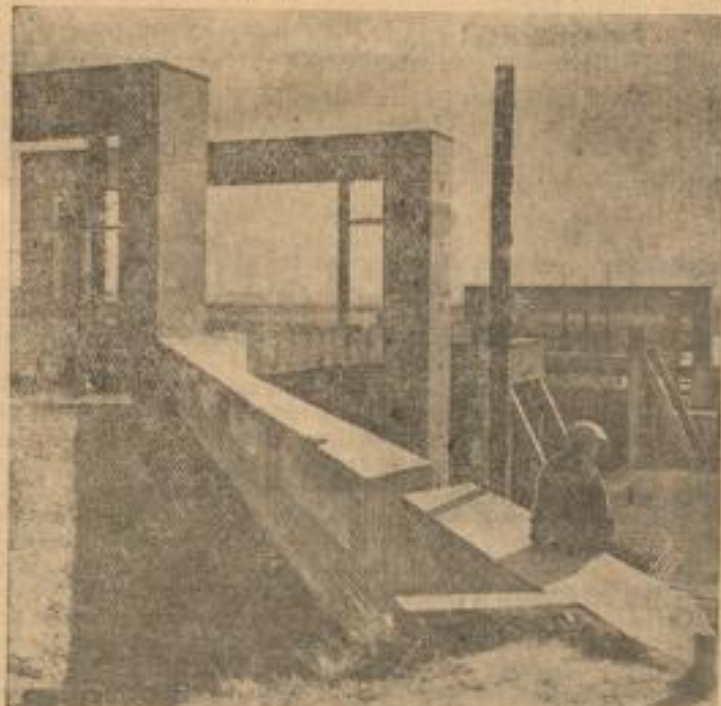
Das Schiffshebewerk Rothensee, das mit der Eröffnung des Mittelkanals in Betrieb genommen wird
