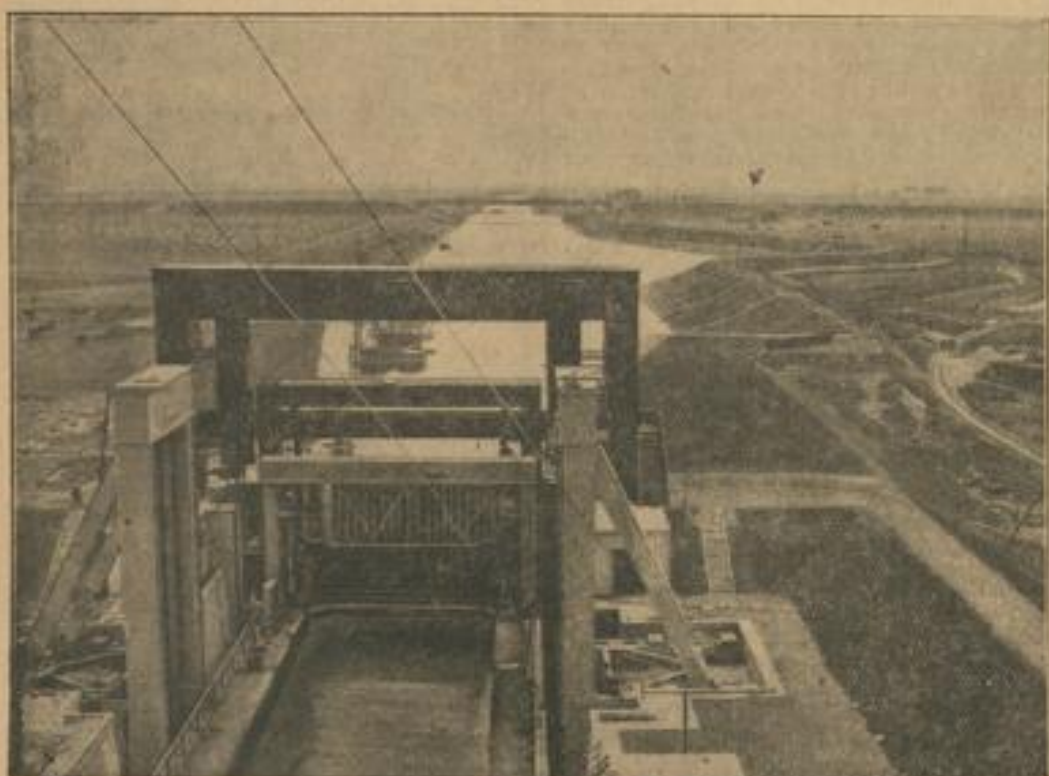
Das neue Schiffsbauwerk Rothensee bei Magdeburg. Rabe Magdeburg geben jetzt die Bauarbeiten an dem neuen Schiffsbauwerk Rothensee, das im Zuge des Mittelkanals einen Rieseunterstand von 19 Meter ausgleichen wird, ihrer Vollenbung entgegen. Schiffe bis zu 1000 Tonnen werden in dem 25 Meter langen Bassin innerhalb von 20 Minuten gehoben werden. Die Eröffnung des Schiffsbauwerks, das wir hier auf unserem Ueberflugsbilde zeigen, soll Anfang September erfolgen. (Atlantik-M.)
