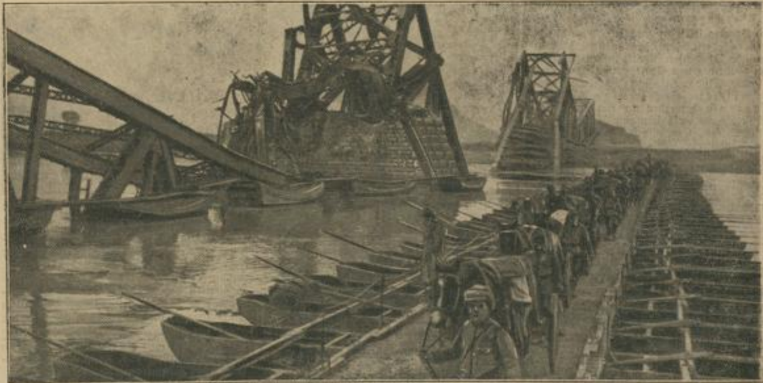
Chinas teuerste Brücke fiel der chinesischen Rückzugdeckung zum Opfer
