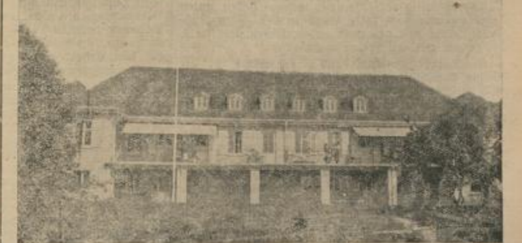
Der Neubau des Tübinger Tropenkinderheims mit Front nach Süden (Bild 1)
