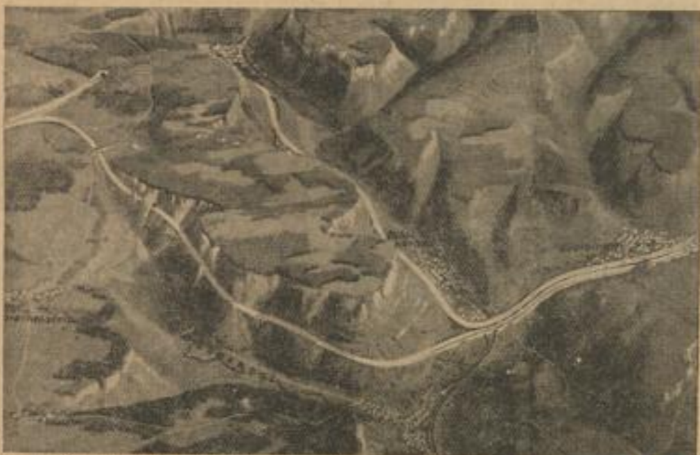
Unsere Reliefkarte läßt deutlich die Teilung der Autobahnstrecke beim Aufstieg auf die Althochfläche zwischen Kirchheim-Teck und Wiesensteig erkennen. Die Teilung der Strecke auf eine Länge von rund 6 km erfolgt bei Mühlhausen und die Wiedervereinigung bei Hohenstadt. Links führt die Autobahn nach Ulm und rechts nach Stuttgart weiter.
