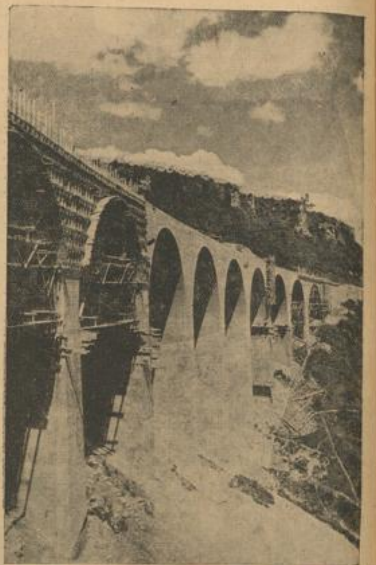
In wichtigen Bögen überspannt die Drackenlochbrücke den Drackensteiner Hang
