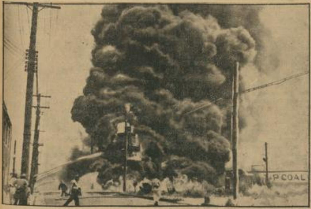
Reisenfeuer in Atlantic-City/USA. Sechs Deltants gerieten in Atlantic-City ohne bisher erkennbare Ursache in Brand. Nach wenigen Minuten war das Gelände der Pure-Oil-Company ein einziges Flammenmeer. Mehr als 100 Personen wurden bei dem Brand verletzt. (Pressephoto, Zander-M.)
