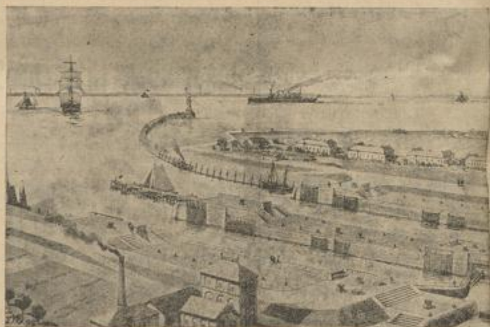
Die Schleusenanlage des Nord-Ostsee-Kanals bei Brunshütten.
