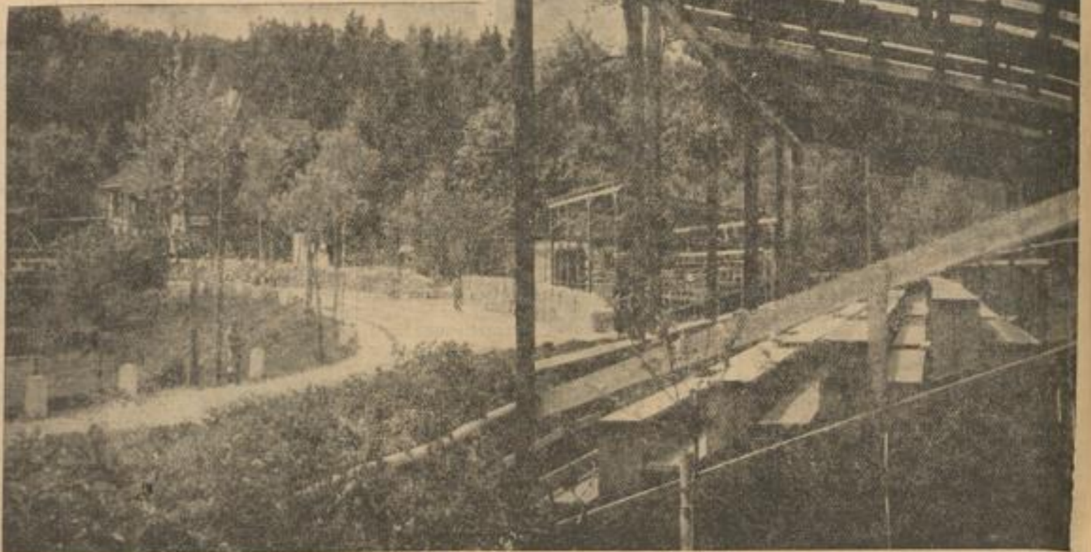
Zwischen grünen Buchen- und Eichenwäldern hindurch führt die Solitude-Rennstrecke. Ein Blick von der im Bau befindlichen Tribüne. (Sv)
