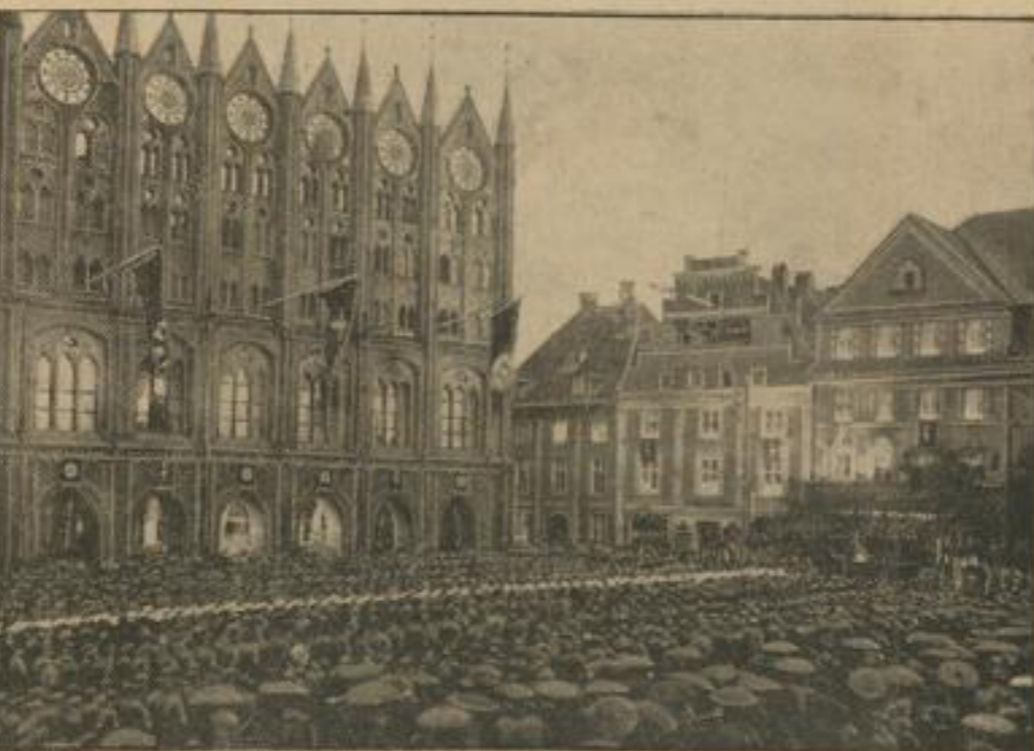
Festliche Stunde in Stralsund Der Rügendam, die Verbindung der Insel Rügen mit Stralsund, dessen Bahn, und Autostraße schon seit längerer Zeit in Betrieb ist, wurde nach seiner endgültigen Vollendung durch Gauleiter Schmedde-Coburg feierlich eingeweiht. Am Abend fand unter Teilnahme der NSDAP und ihrer Gliederungen sowie der ganzen Bevölkerung Stralsunds und zahlreicher Bewohner der Insel Rügen auf dem Alten Markt in Stralsund eine festliche Kundgebung statt. (Weltsbild, Erich Jander, R.)
