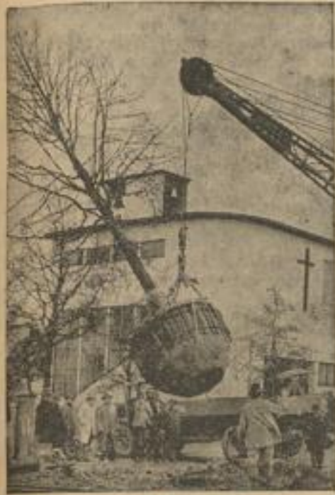
Der zu verpflanzende Baum wird an seinem neuen Standort mit einem Kranen gehoben und in das Pflanzenloch gesetzt. (Kochlichtnam: Zeit.)
