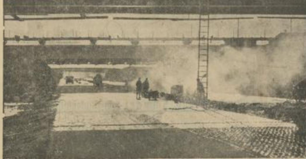
Ruhr-Autobahn im Zeichen kühlerer Brücken. Am 12. Dezember wird das Teilstück Düsseldorf-Nord-Oberhausen der Ruhrgebiets-Autobahn dem Verkehr übergeben werden. Unsere Aufnahme gewährt in interessanter Perspektive einen Durchblick auf die Arbeiten im Oberhausener Gebiet der Ruhr-Autobahn, der eine ganze Anzahl von horizontal gespannten Stahlbrücken zu einer eindrucksvoll räumlichen Gliederung verhilft. (Weltbild, M.)
