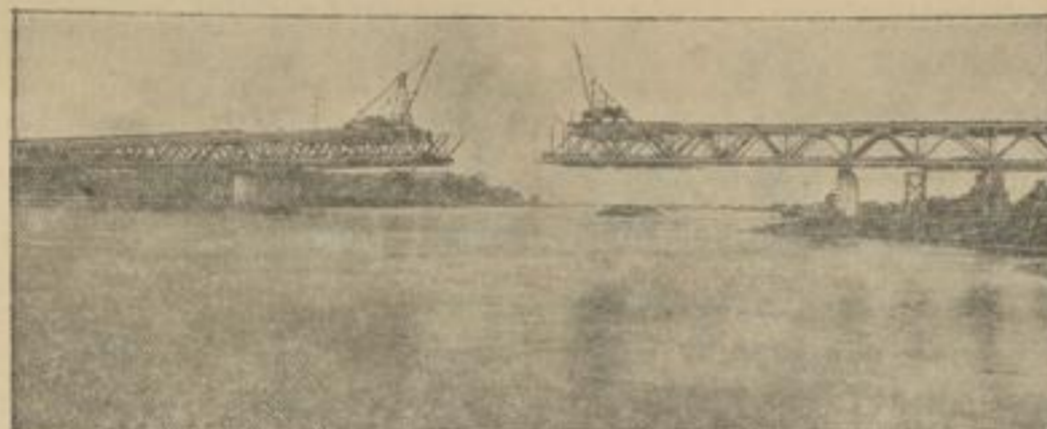
Sold stehen sie zusammen. So entsteht die Elbbrücke bei Hohenwarthe. In freiem Vordau nähern sich beide Teile, um sich über der Strommitte zu treffen. (Pressefoto, M.)
