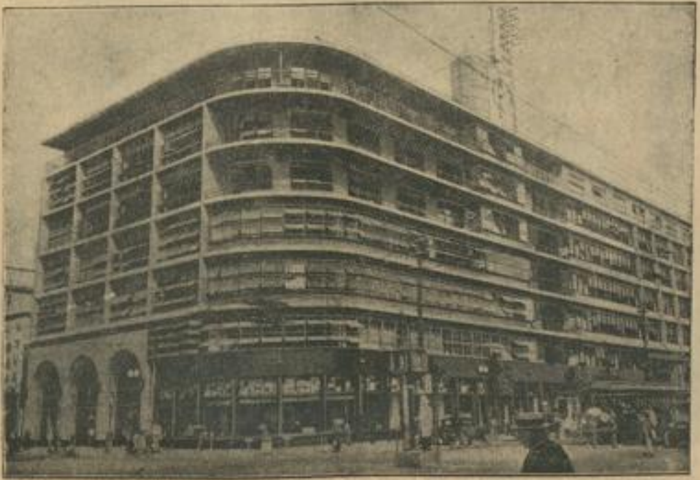
Tokio — das Newyork des Ostens. Unser Bild zeigt eines der großen Warenhäuser in Japan (Bild: RZ-Presse Archiv)
