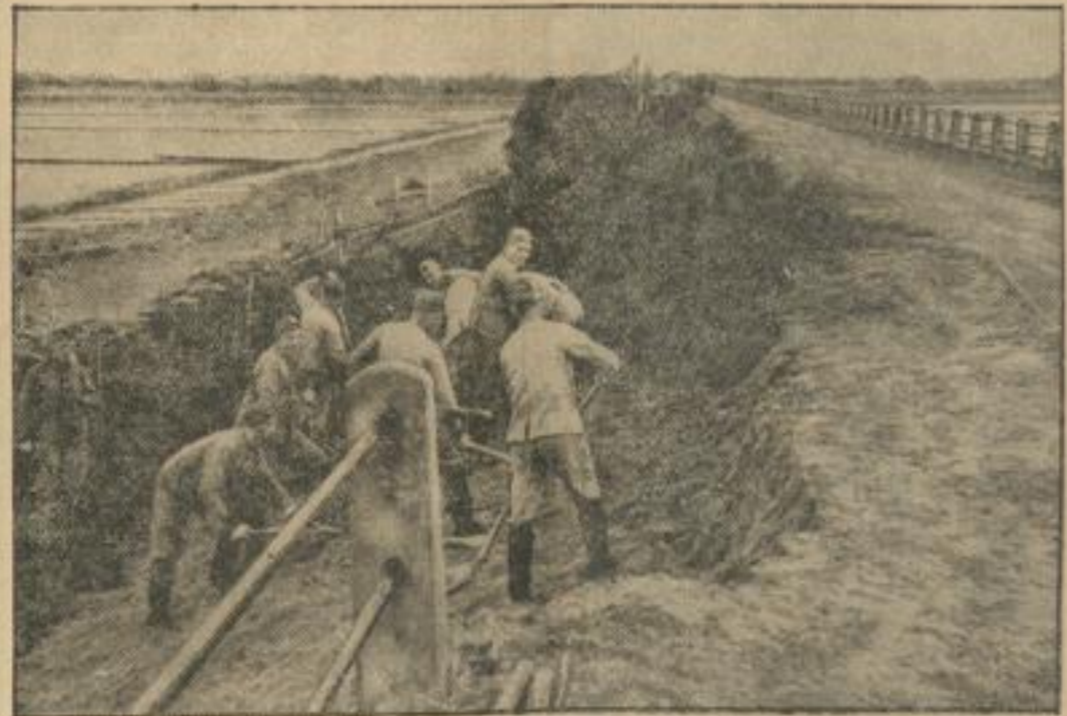
Der Nordstrander Dam wird wieder hergestellt
