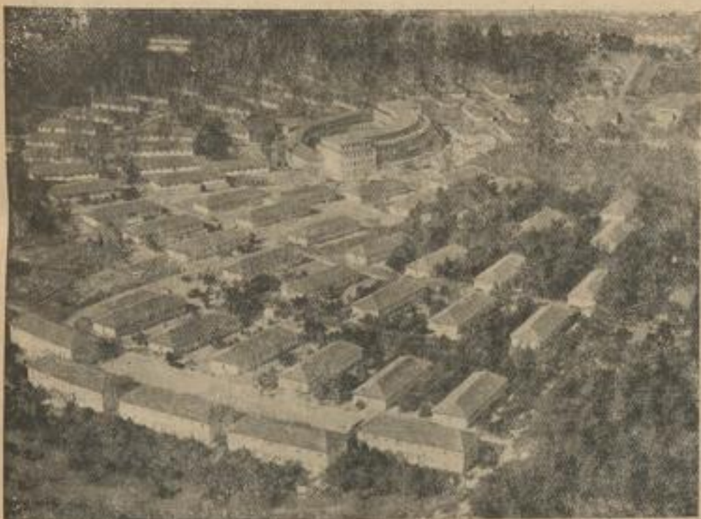
Das Olympische Dorf fertiggestellt
