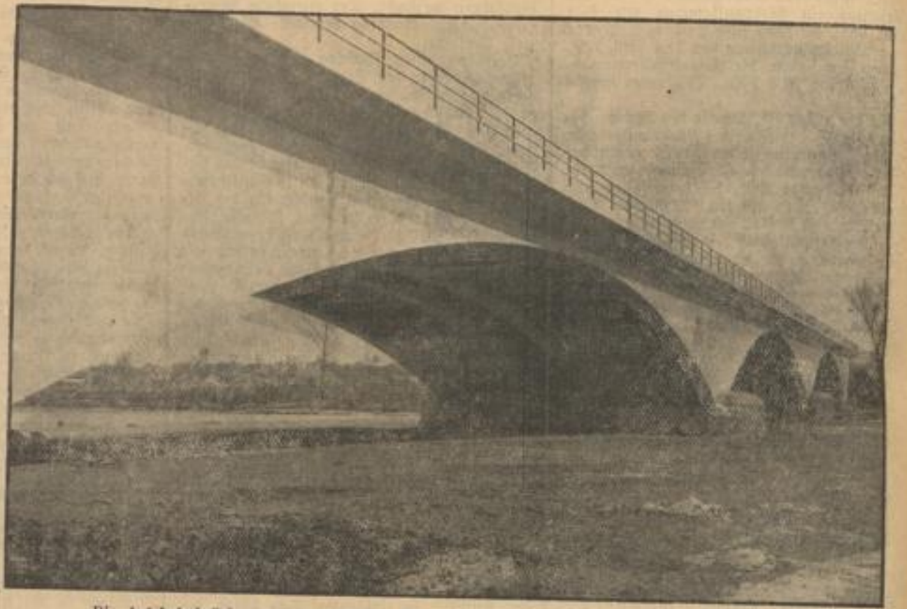
Die Autobahnbrücke bei Unterboihingen überspannt 176 m lang und 6 m hoch den Neckar
