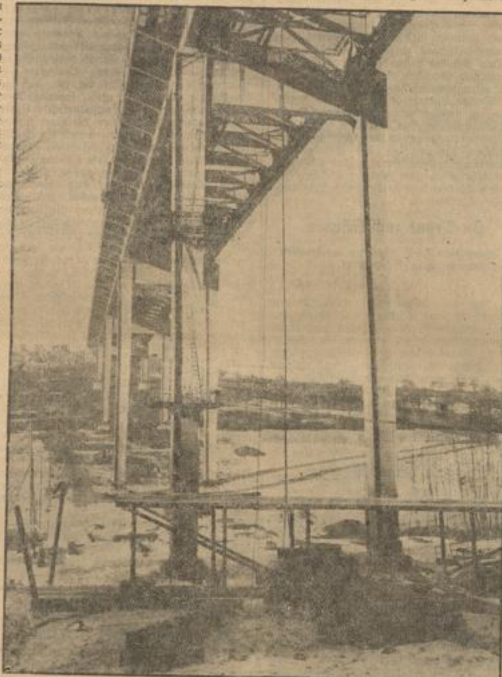
In acht Monaten wurde die Stahlkonstruktion des Sulzbachviaduktes bei Denkendorf auf den Fildern mit seiner Länge von 365 m und einer Höhe von 42 m errichtet
