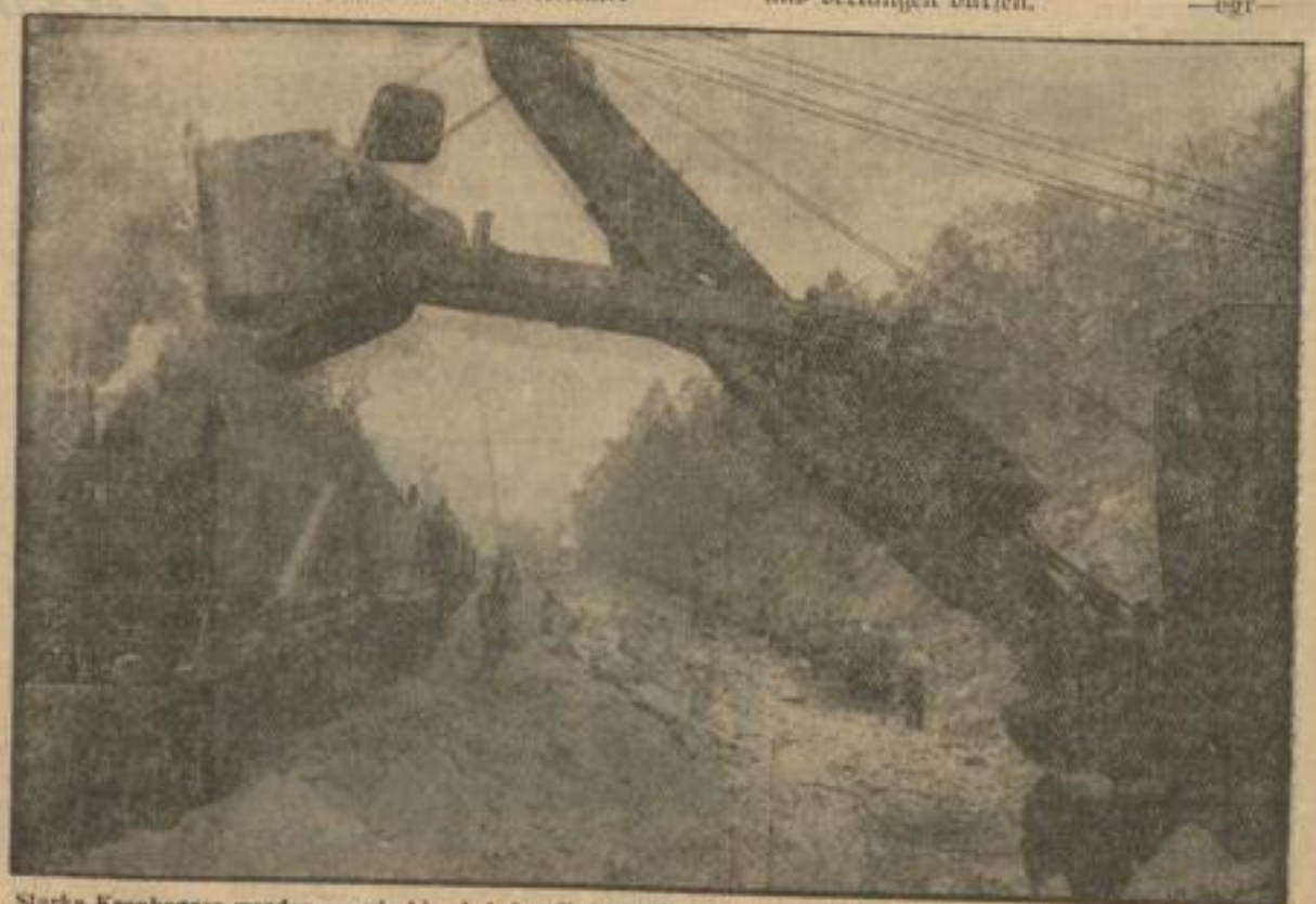
Starke Kranbagger werden — wie hier bei den Erdarbeiten im Waldstück „Dierlewang“ — bei Rohr überall eingesetzt (Zünftliche Bilder: Arbeit der D.M.R.-Straßengr., Aufnahme: Dipl.-Ing. Subelmaier)
