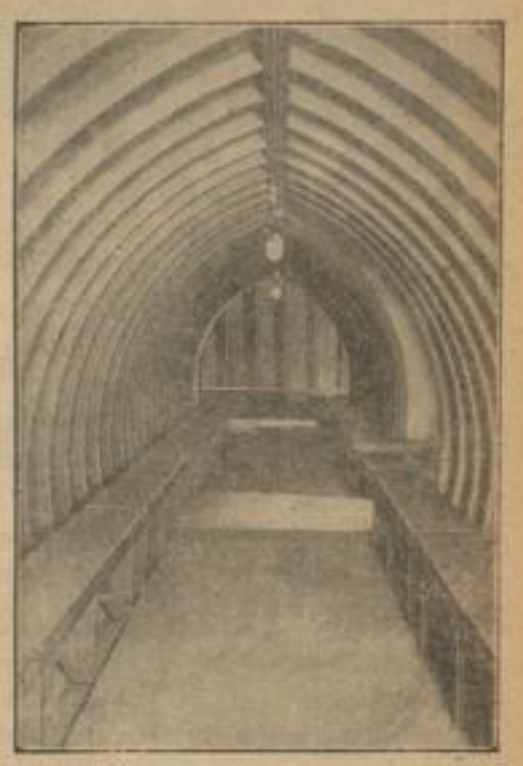
Innere eines Schutzraumes aus Stahlblechen
