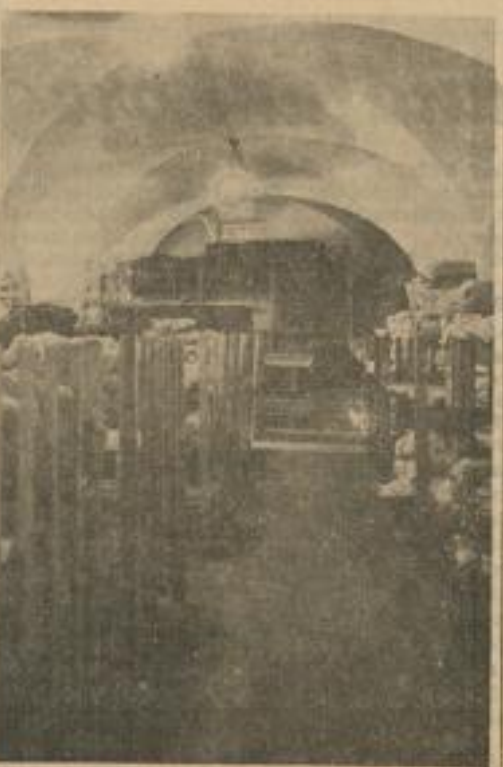
In der früheren Reithalle sind heute Garnlager untergebracht. (3 Bilder: Werkfoto.)
