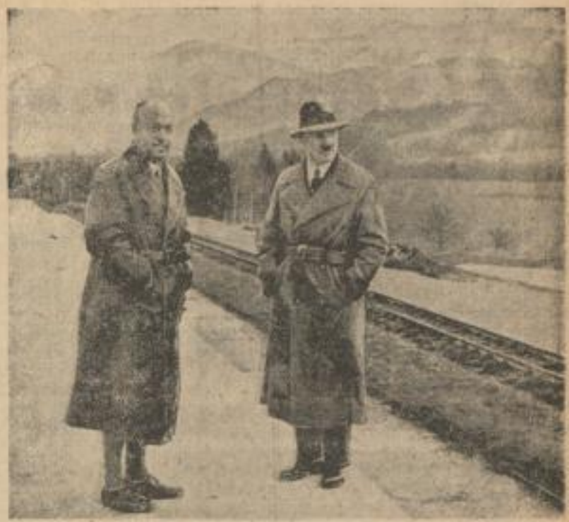
Der im Zuge der Reichsautobahn München-Landsgrenze fertiggestellte Bauabschnitt bis Rosenheim wurde vom Führer in Begleitung des Generalinspektors für das deutsche Straßennetzen, Dr. Todt, besichtigt. Dieser Bauabschnitt gehört zu den interessantesten und, wie das Bild zeigt, auch landschaftlich schönsten. (Goffin.)
