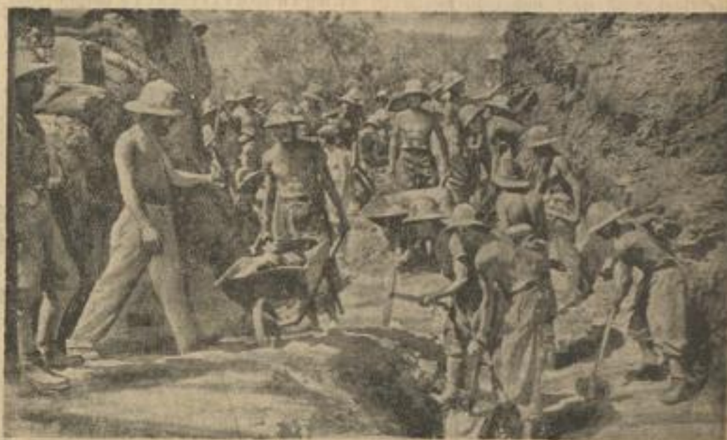
Vor allem — Sicherung des Nachschubs. Nach wie vor legt die italienische Heeresführung in Abessinien den größten Wert auf gute Straßen, welche die Vorladung der kämpfenden Truppe mit der Etappe bilden. Unser Bild zeigt eine italienische Kolonne beim Straßenbau. Mit entblößtem Oberkörper verrichten die Arbeiter in der glühenden Sonne ihr schweres Tagewerk. (Schel Silberblenk, R.)
