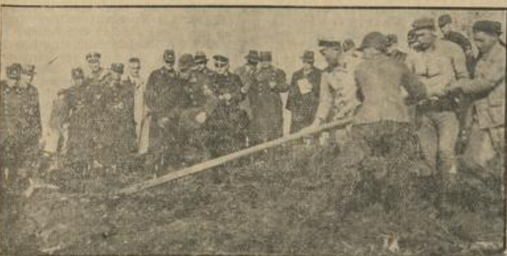
Der „Waldteufel“ wird angesetzt. Im Hintergrund die Teilnehmer an der Besichtigungsfahrt, in ihrer Mitte Bauarbeitsführer Müller.
