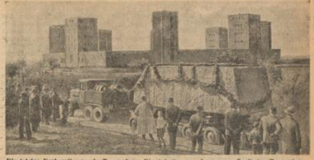
Die letzten Vorbereitungen in Tannenberg. Die Arbeiten an der neuen Gruft im Tannenberg-Nationaldenkmal, in der bekanntlich der verewigte Reichspräsident seine letzte Ruhe finden wird, schreitet rüstig vorwärts. Die feierliche Ueberführung des Sarkophags wird bekanntlich am 2. Oktober, dem 88. Geburtstag des Generalfeldmarschalls, erfolgen. Unser Bild zeigt die Ankunft des riesigen Hindenburg-Findlings für den Eingang zur Gruft. (Gentrich Seemann, R.)
