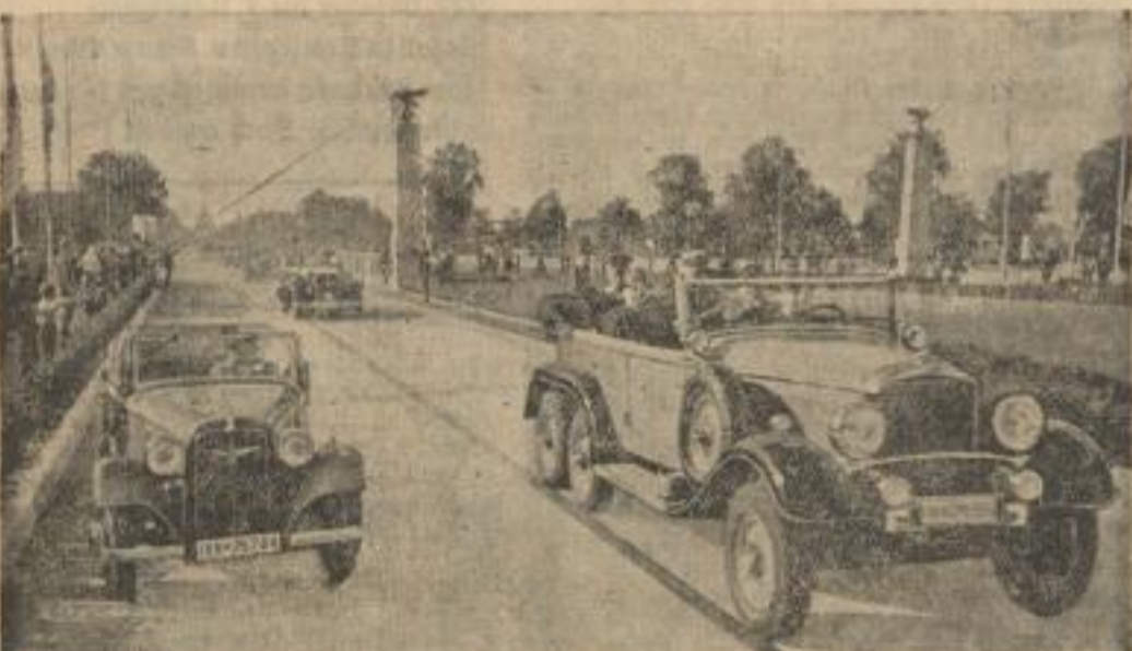
Reichsautobahn Frankfurt-Heidelberg fertig. Nach genau zweijähriger Bauzeit ist nunmehr die gesamte Strecke der Reichsautobahn Frankfurt-Darmstadt-Mannheim-Heidelberg fertiggestellt worden. Aus diesem Anlaß fand unter Führung des Generalinspektors für das deutsche Straßenwesen, Dr.-Ing. Todt, eine Besichtigung der neuen Strecke statt. Unser Bild zeigt die Autokolonne der Gäste mit dem Wagen des Generalinspektors an der Spitze bei der Ausfahrt aus Mannheim.
