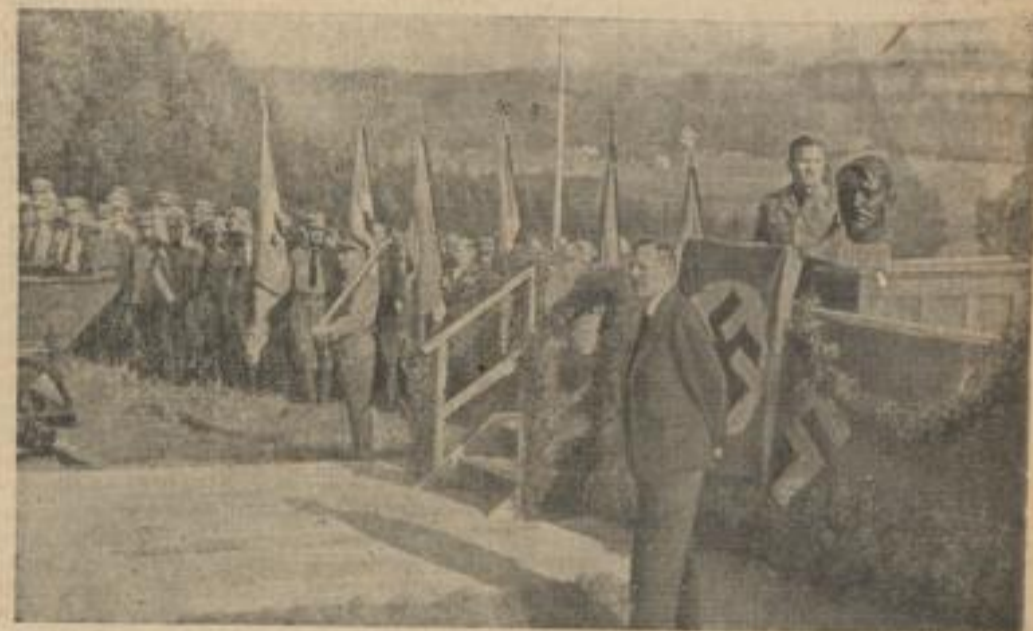
Der erste Spatenstich zur Reichssteuerschule. In Hersching am Ammersee erfolgte der erste Spatenstich zum Gebäude der Reichssteuerschule, die den Zweck hat, den Mangel an geeigneten Arbeitskräften zu mildern und die Leistungsfähigkeit unserer Verwaltung als Ganzes zu erhöhen. Auf unserem Bilde hält Staatssekretär Reinhardt die Begrüßungsansprache, davor der Reichsfinanzminister Graf Schwerin von Krosigk.
