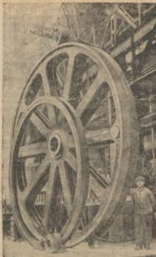
Ein Meisterstück deutscher Gußstahltechnik. In den Geisenkirchener Gußstahlwerken wurde dieses über 5 Meter hohe Stirnrad, das für einen Drehkran bestimmt ist, hergestellt. (Gönn, R.)
