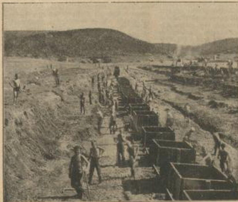
5000 Volksgenossen arbeiten am Mittellandkanal
