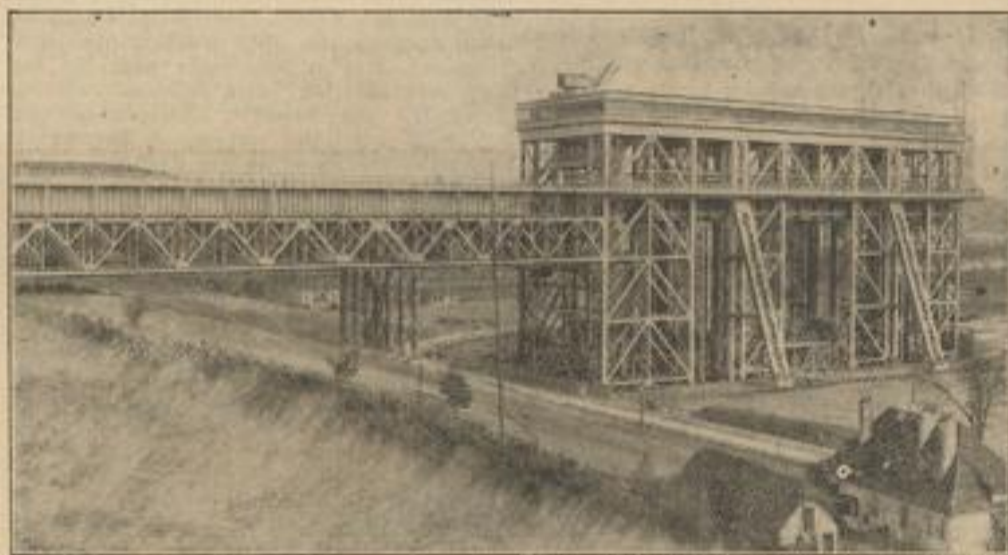
Das 1934 eingeweihte Schiffsbauwerk Niederfinow hebt in 20 Minuten vier Finowkähne bis auf eine Höhe von 62 Meter
